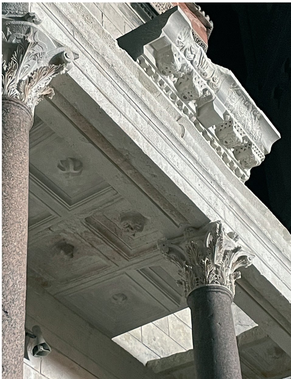
Pogled na lakunar tijekom restauracije
